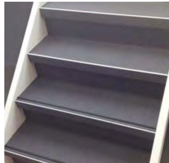
Figura 1 (detalle escalón con protección)
